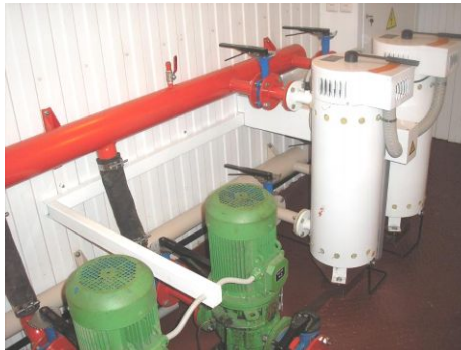
Рис. № 3 Электроротельная ЭК-200БК, ЭК-200БКм. Вид изнутри.
